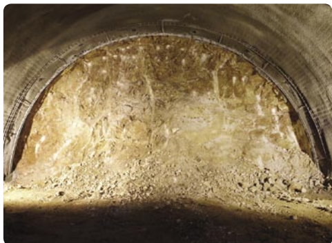
Pohled na čelbu prvního tomického tunelu
