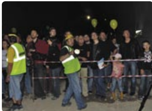
Realizační tým divize 1 v čele s Josefem Bačou (osvětluje tunel) ochotně popisoval návštěvníkům ražbu tunelů
