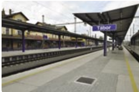
Největší podíl prací připadl na železniční stanici Tábor, která tím dosáhla evropských standardů
