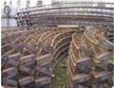
Výztužné příhradové oblouky jsou součástí řady velkých tunelových staveb
