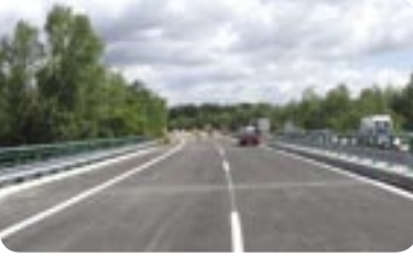
OPRAVA MOSTU V BRANDÝSE JE ZA PŮLKOU
