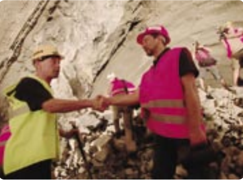
Razičské osádky Subterra a Skanska se po prorážce pozdravily
