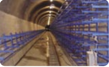
KOLEKTOR KOLIŠTĚ PŘED DOKONČENÍM
