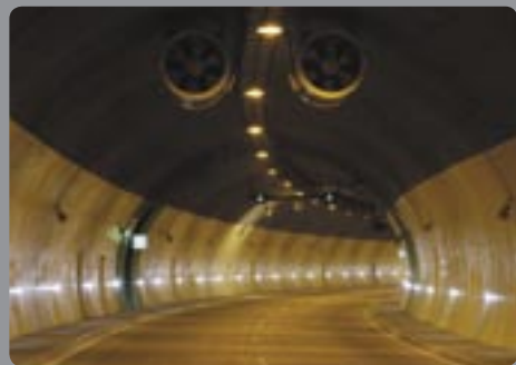
Dálnice D8 – tunel Panenská
