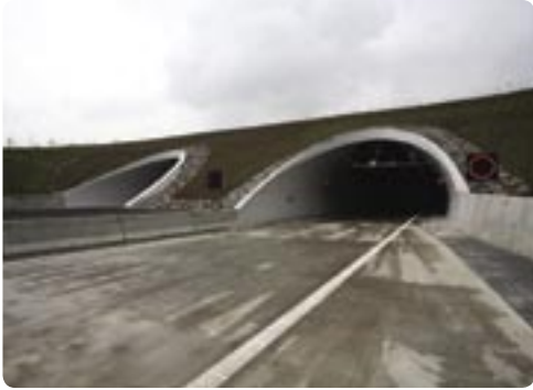
Tunelové tubusy mizející do podzemí mají za úkol především ochránit přilehlé lázně Hýlov od dopravního ruchu
