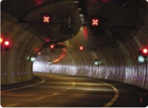
První dálniční tunel na Ostravsku splňuje nejnáročnější kritéria bezpečnosti silničního provozu
