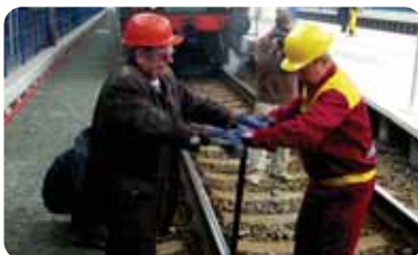
SYMBOLICKÉ DOTAŽENÍ ŠROUBU UKONČILO STAVBU
